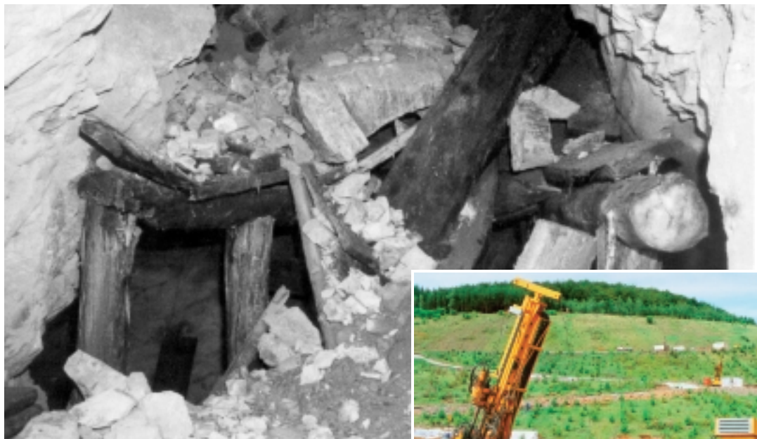
Versatzbohrung am Standort Schlema zur Verfüllung tagesnaher Hohlräume
