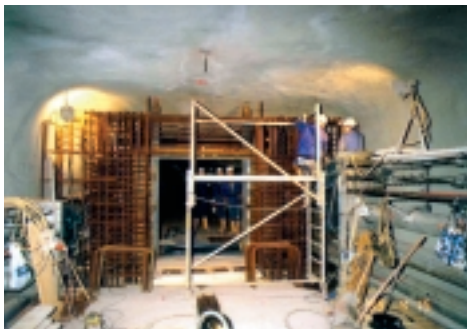
Dammbauarbeiten in der Grube Königstein zur Beeinflussung der späteren untertägigen Wasserzirkulation
