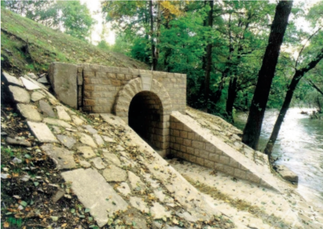
Einleitungsstelle für gereinigtes Flutungswasser in die Zwickauer Mulde
