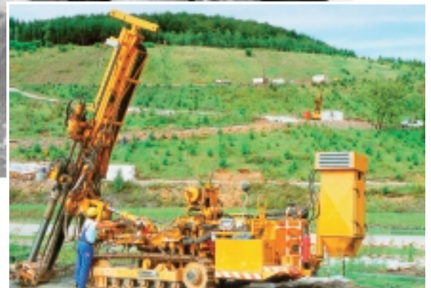
Versatzbohrung am Standort Schlema zur Verfüllung tagesnaher Hohlräume
