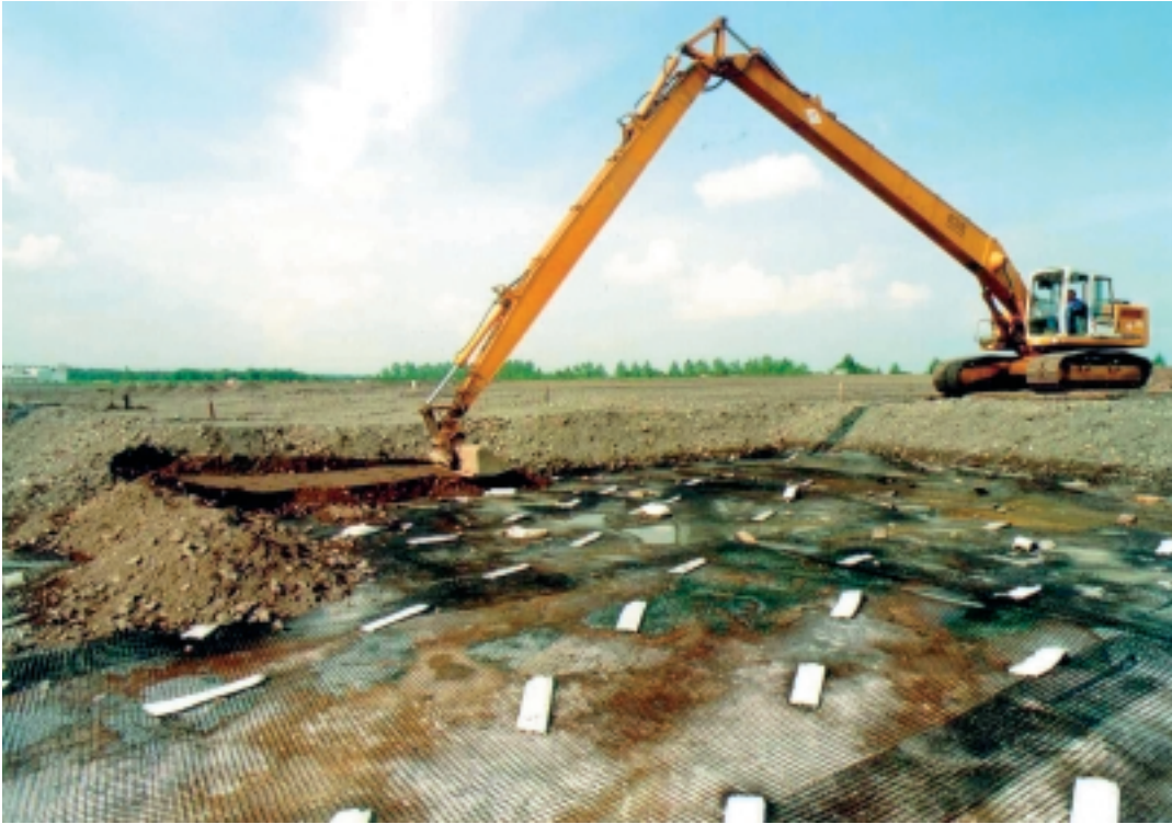
Auftragen der Zwischenabdeckung auf noch nicht standfeste, jedoch bereits mit Geotextilien abgedeckte Tailingsfläche
