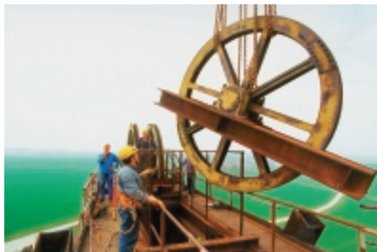
Demontage der Seilscheibe eines Fördergerüsts am Standort Ronneburg
