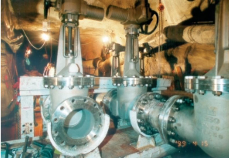
Wechselvorrichtung für großdimensionierte Schieber im Sanierungsbetrieb Königstein
